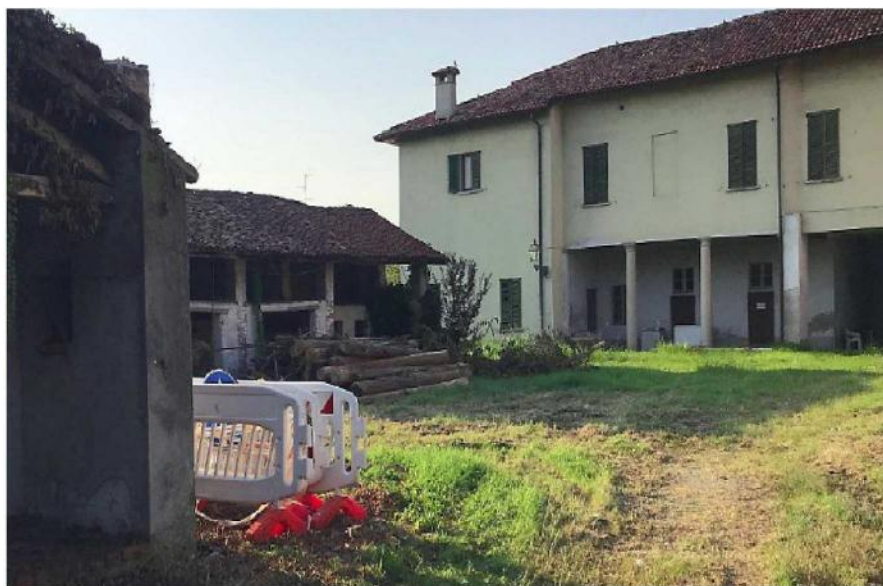
La corte Berneri oggi, abbandonata e ridotta a un rudere
